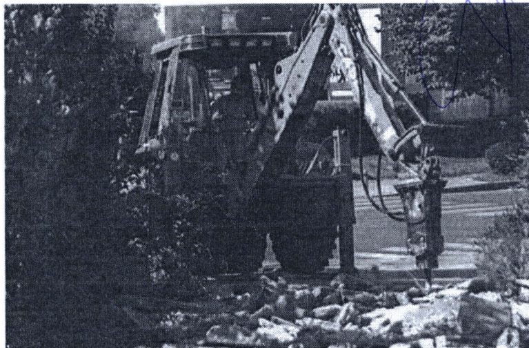
Премахване на съществуващи настилки
