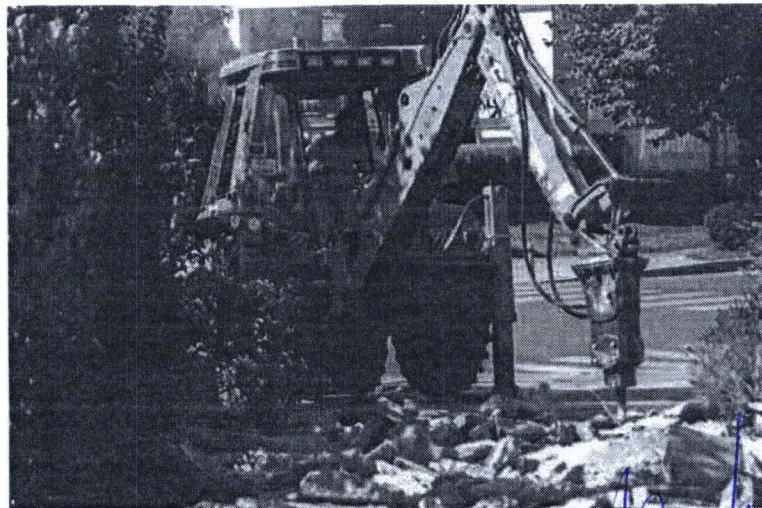
Премахване на съществуващи настилки
