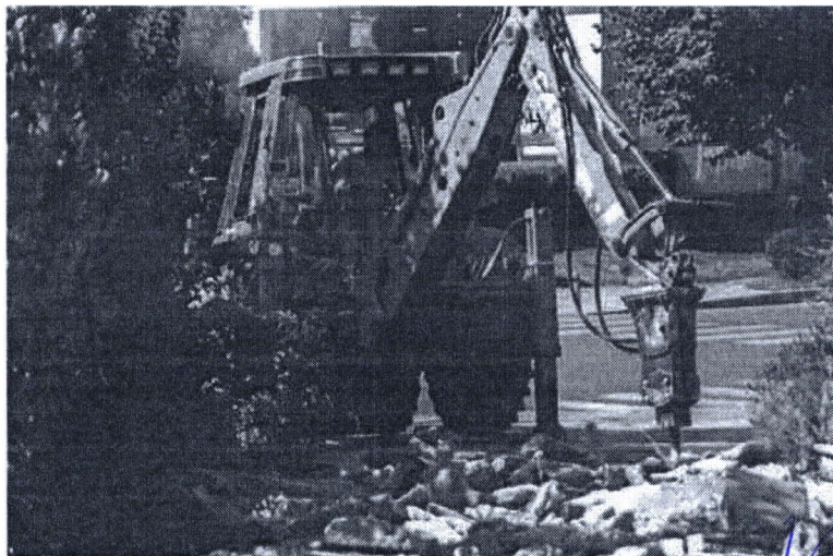
Премахване на съществуващи настилки
